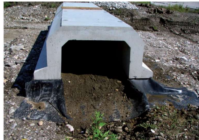
Abb. 6: Stelztunnel mit Foliendichtung (Foto: M. KYEK)
